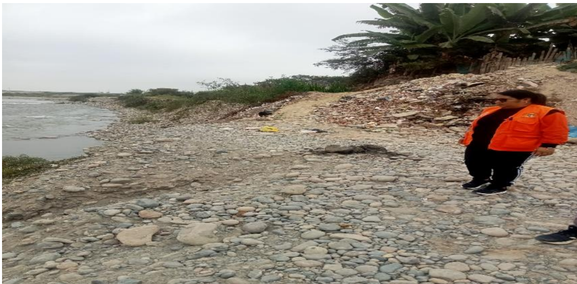
FFIGURA N°02: MARGEN DERECHA DEL RIO PISCO SE ESTA EROSIONANDO EN LOS AÑOS 2023, 2024 Y 2025, PONIENDO EN RIESGO LA CAPTACION DE LA BOCATOMA CAUCATO.
